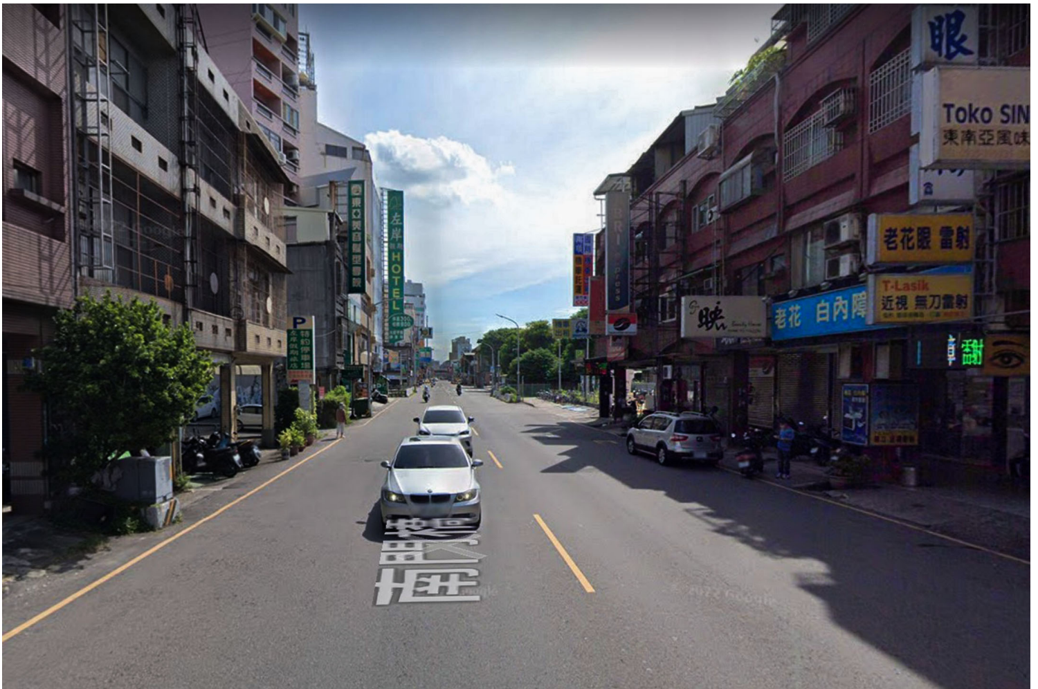
新竹市中华路二段。台湾市区道路经常有车道过宽、路肩空间暧昧不明的问题，除了无法有效规范行车动线、增加风险之外，也容易导致违规停车。图：Google Map 截图
