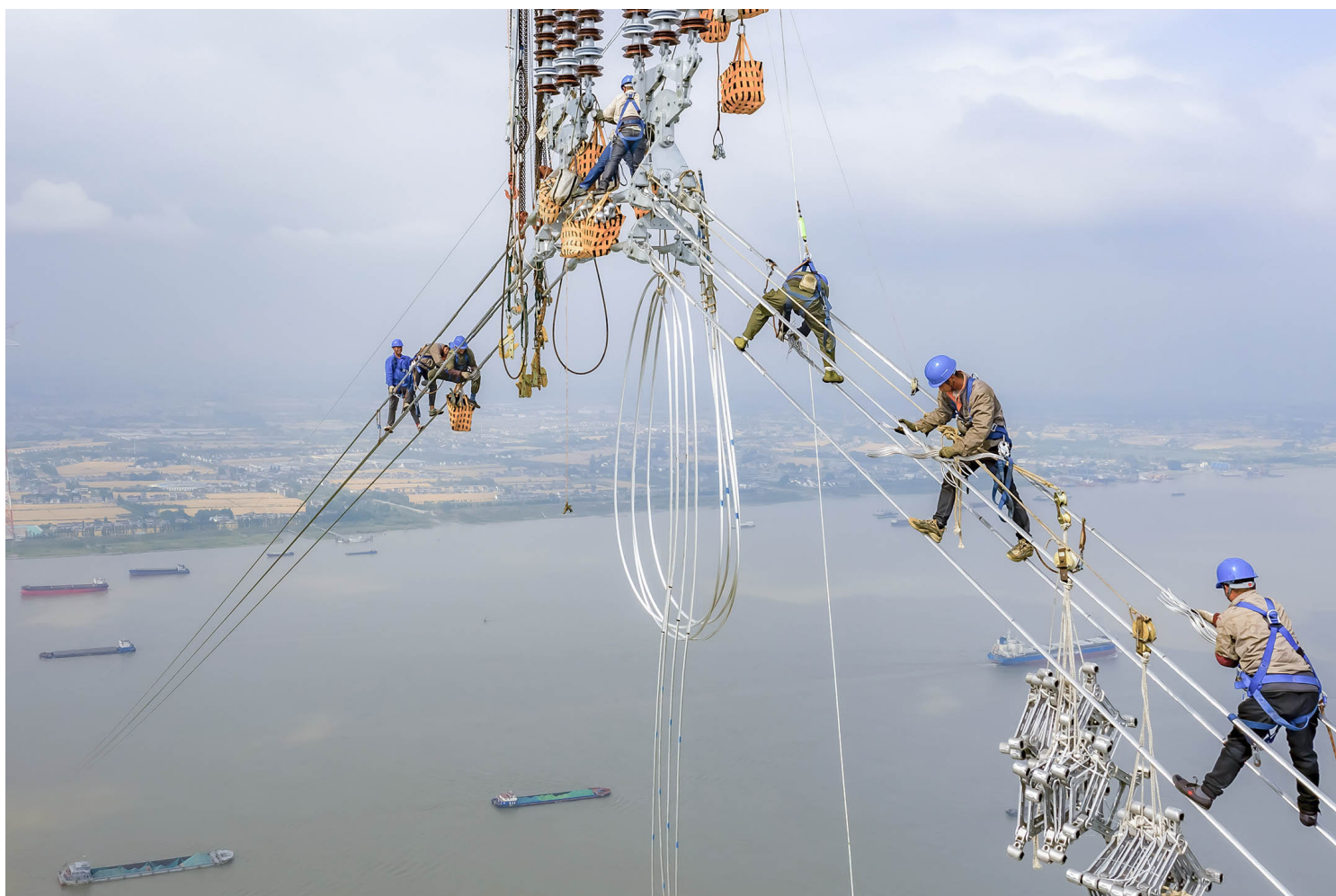
2022年6月1日，江苏省台州市，工人们在长江沿岸的输电塔上安装电线。摄：Shi Jun/VCG via Getty Images
