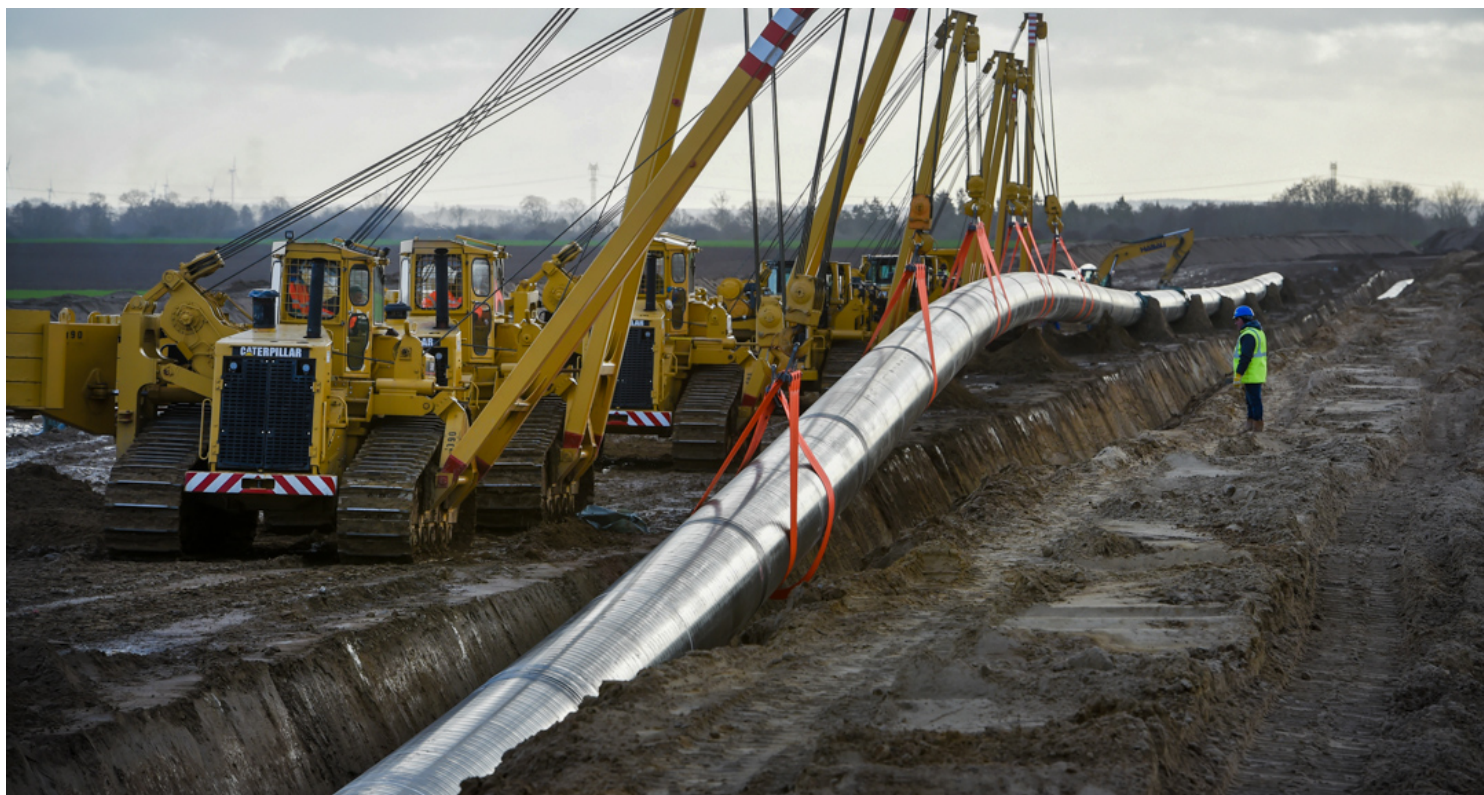
2018年12月4日，工人正在接驳由德国连接至俄罗斯的北溪二号天然气管道。摄：Stefan Sauer/picture alliance via Getty Images
