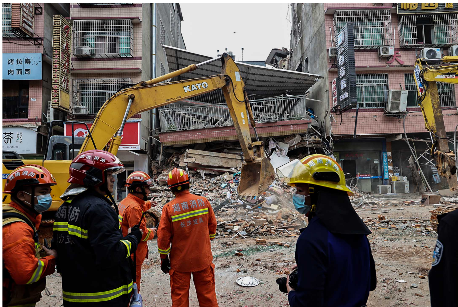
2022年4月29日，湖南长沙，救援人员于自建房的倒塌现场工作。图：VCG via Getty Images
