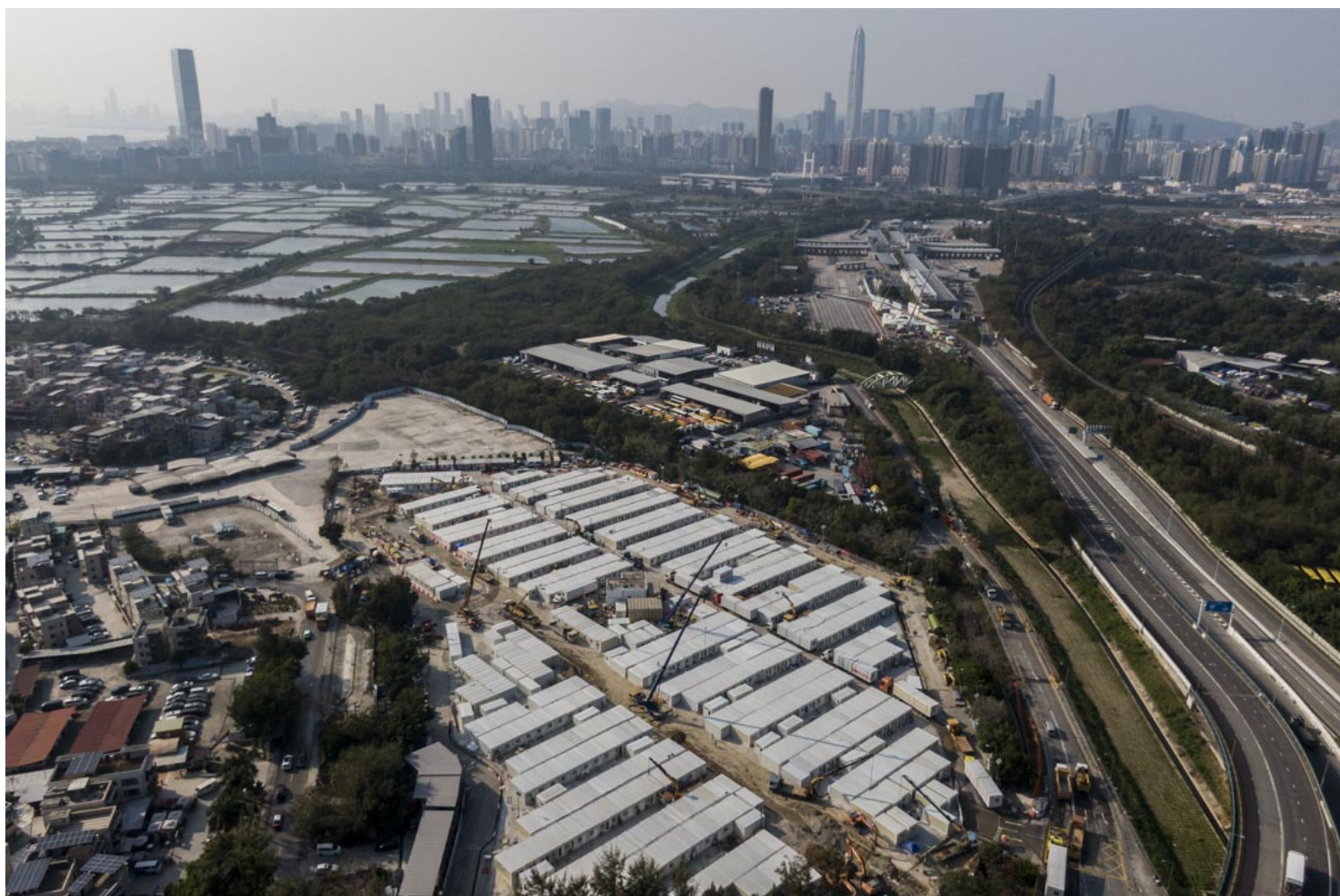
2022年3月3日，政府称下一个落成的方舱医院位于前新田购物城，已正在赶工，现场所见放置了大批隔离平房。摄：林振东/端传媒
