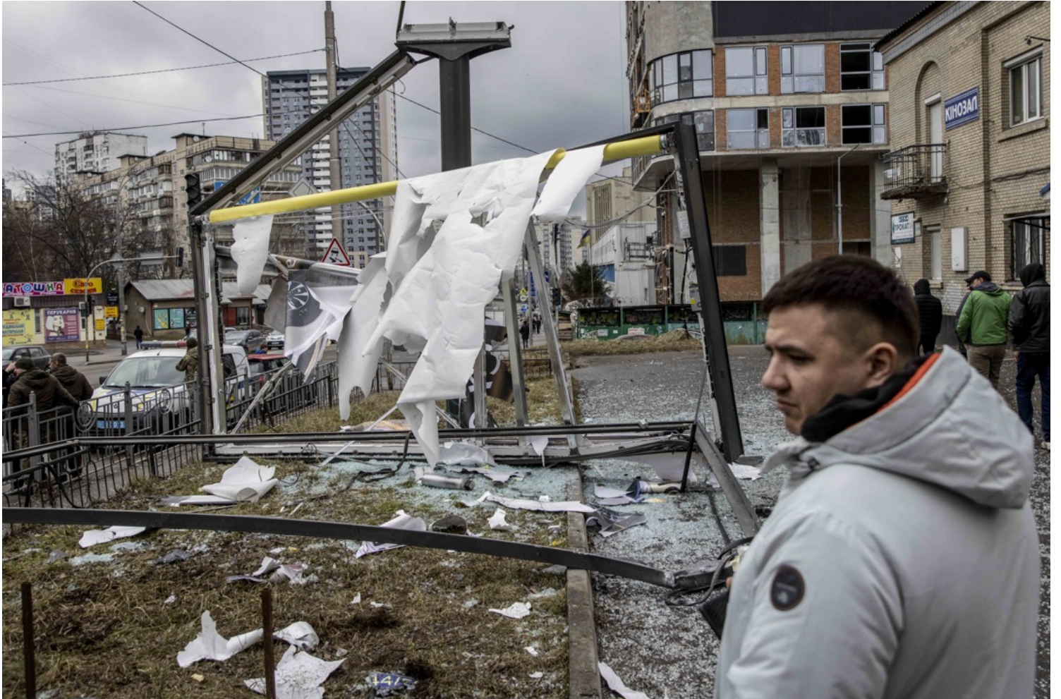
2022年2月24日，乌克兰首都基辅，俄罗斯发射飞弹击中市内建筑，市民在旁围观。摄：Chris McGrath/Getty Images
