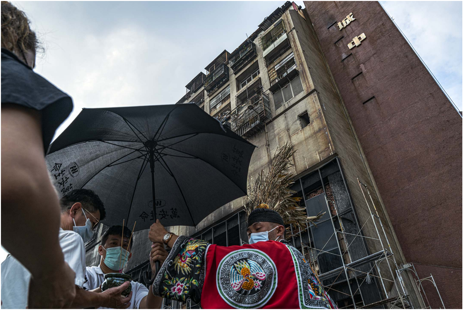
2021年10月15日台湾高雄城中城大楼，“城中城”大楼大火造成至少46人死亡、43人受伤，遇难者亲人在大楼下悼念拜祭。摄：陈焯輝/端传媒
